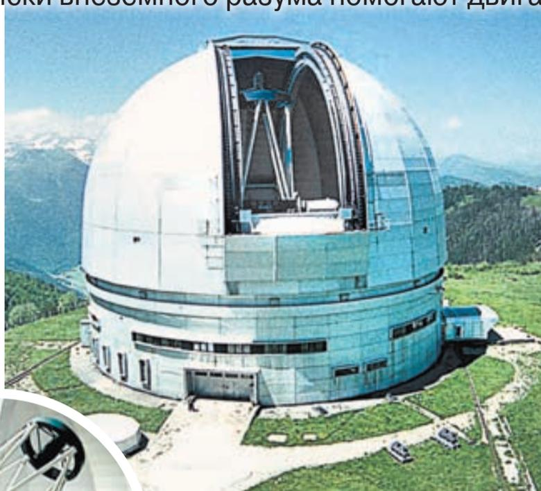
Башня 6-метрового телескопа БТА. Высота сооружения – 53 м.
