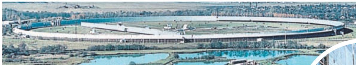
Радиотелескоп РАТАН-600. Диаметр кругового отражателя – 576 м.
