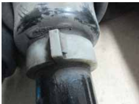
Иллюстрация 4. Некорректная установка! Мастер забыл удалить клипсу после монтажа.
