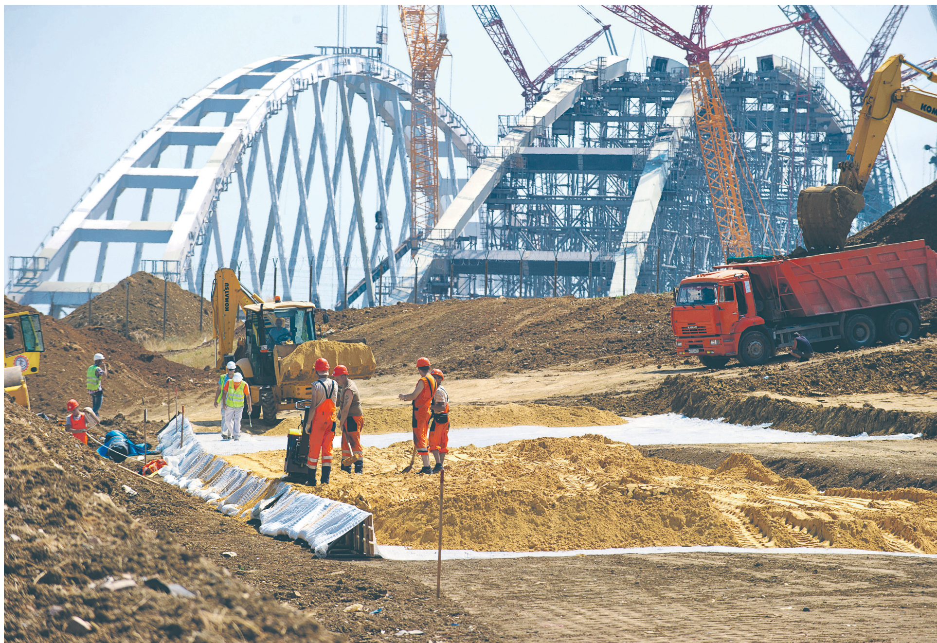
Открытие автомобильной части Крымского моста прошло на полгода раньше изначально планировавшегося срока, а вот работы на подходах к мосту стали долгостроем
