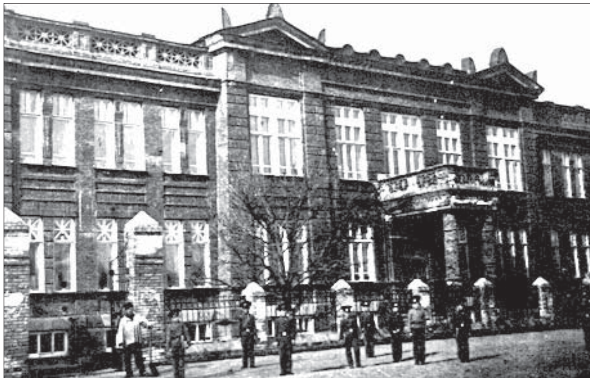
Здание гимназии построили в рекордно короткие сроки.
