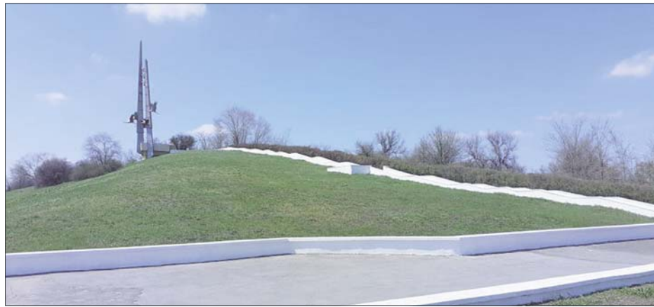
Мемориальный комплекс «Невернувшимся» отремонтировали и благоустроили.
