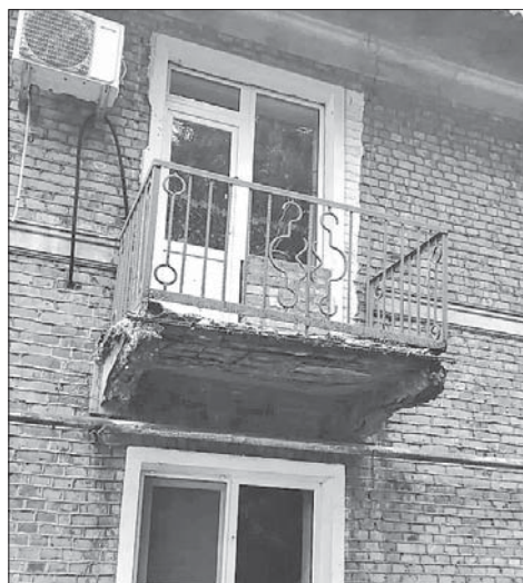
Балкон в многоквартирном доме по улице Шверника находится в аварийном состоянии. Управляющая компания опечатала балкон, пользоваться им хозяйка квартиры не может.
