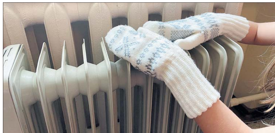
Ещё несколько дней шахтинцы будут жить без отопления.
