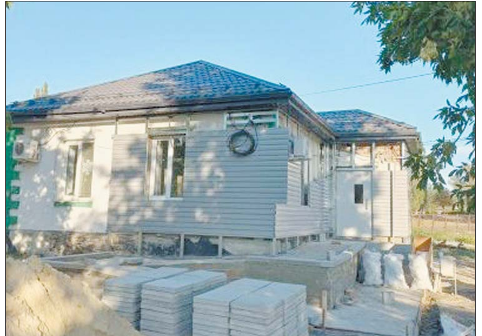
В хуторе Красный Кут приступили к ремонту отделения почты.
