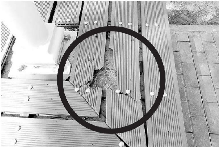
Из-за неправильного монтажа сиденья скамеек разваливаются.
