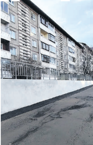
Отремонтирована подпорная стенка на ул. Баумана, 184-186.
