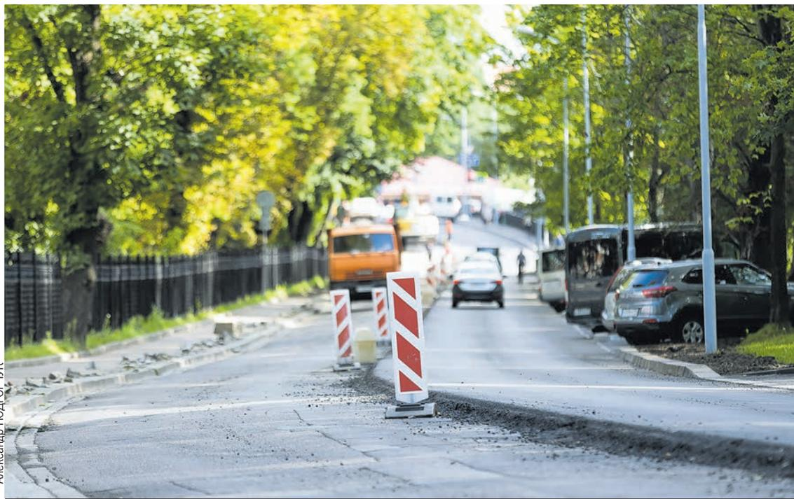
На Гаражной пока готова только одна полоса. Асфальт укладывают в два слоя.
