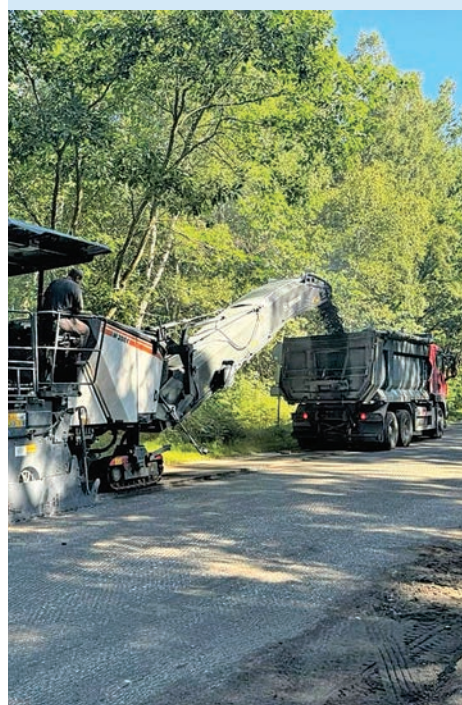
Примерно через два месяца объект будет сдан.
