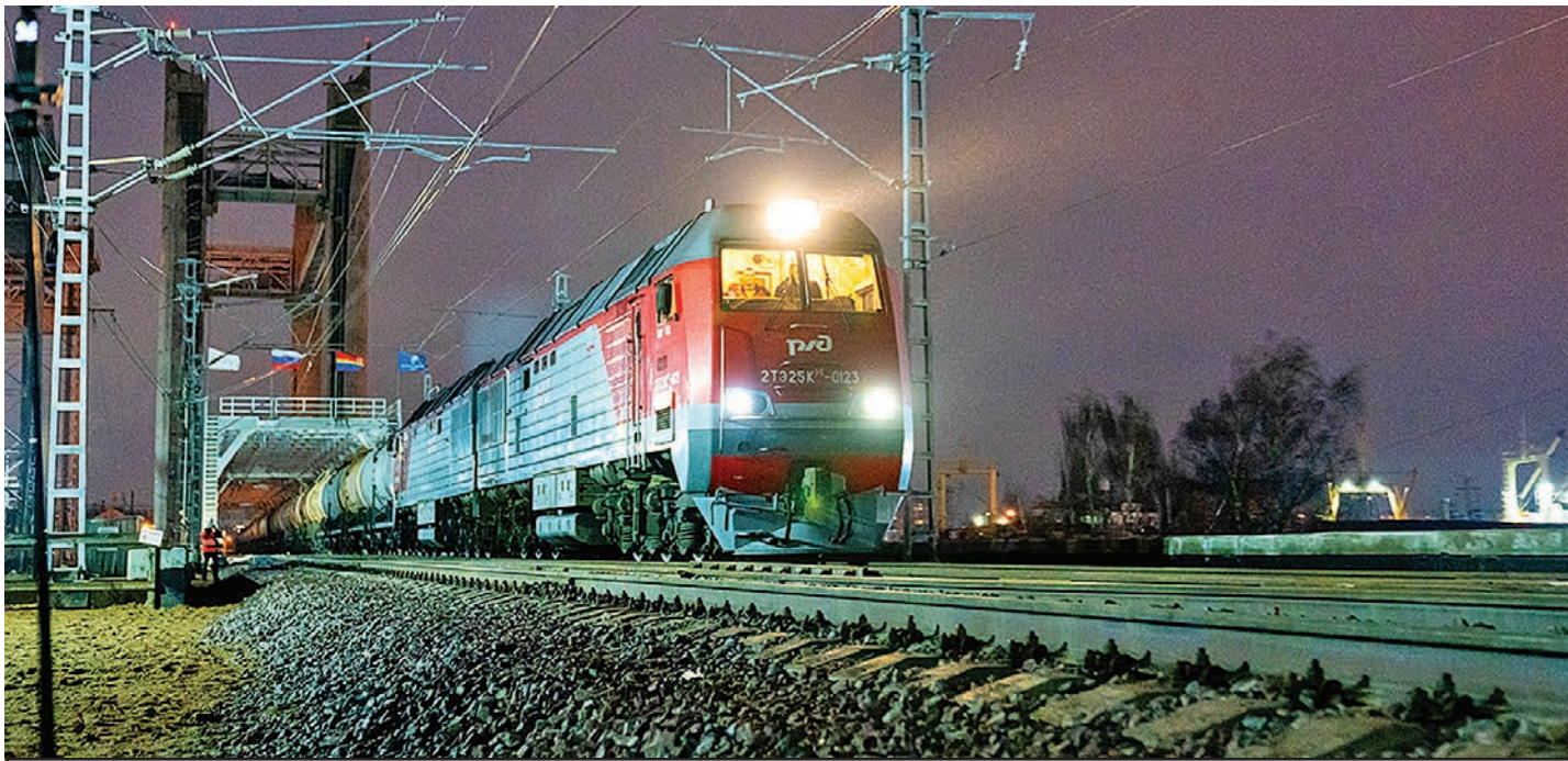
Длина сооружения составляет 237,3 метра.
