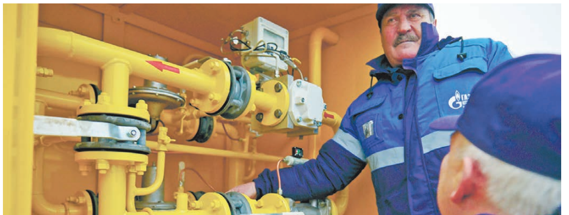
В 2017 году были построены и введены в эксплуатацию четыре участка газопроводов.
