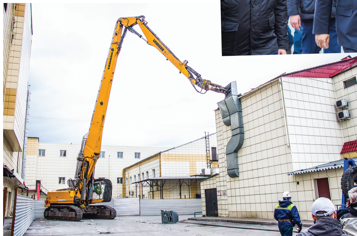
Все работы по демонтажу здания будут вести при помощи техники: для безопасности рабочие на объекты заходить не будут.
