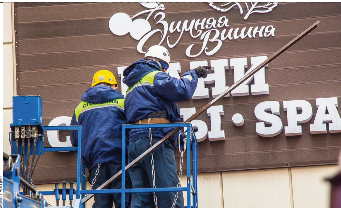
Демонтаж комплекса зданий торгово-развлекательного центра начали со второстепенных строений, чтобы расчистить площадку для работ на основном.
