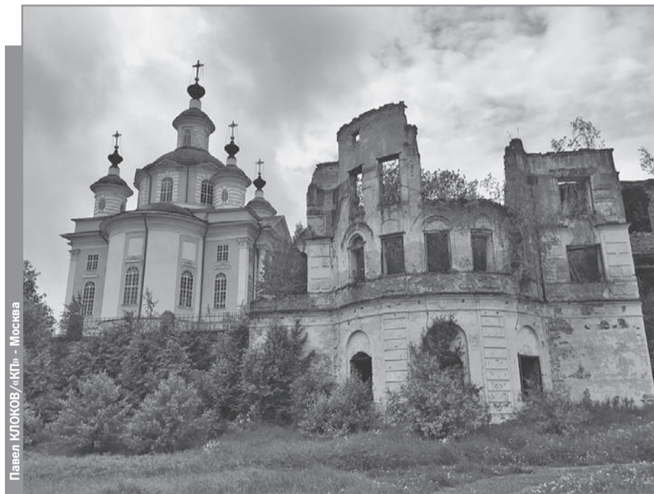
Вознесенский собор (слева) и Успенская церковь, которую тоже будут восстанавливать.
