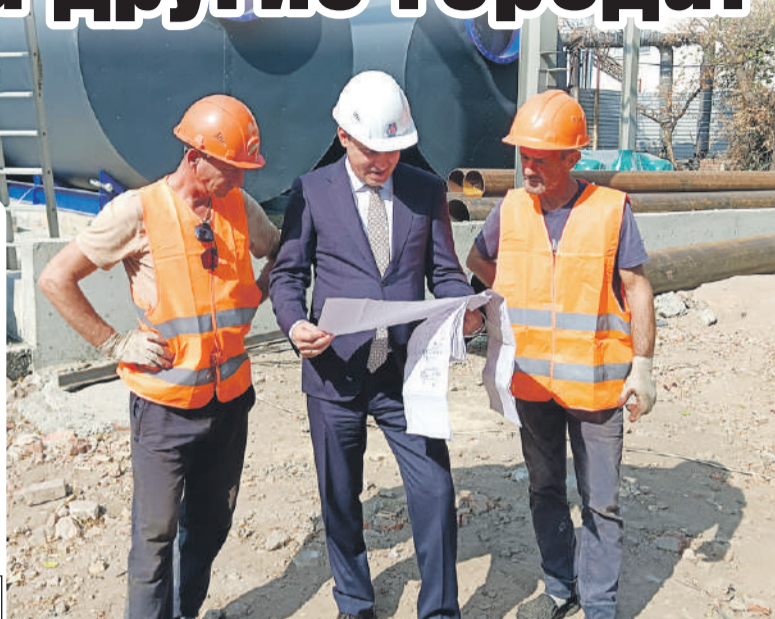
Во время технического перевооружения котельной на ул. Мира: теперь это полноценный и стабильно работающий источник тепла.
