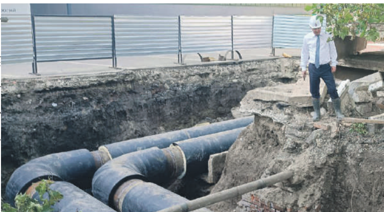
В Комсомольском районе всего за две недели поменяли крупный участок магистральной теплотсети.
