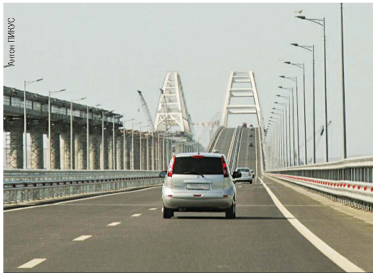
Строительство Крымского моста дало новый толчок к развитию экономики.
