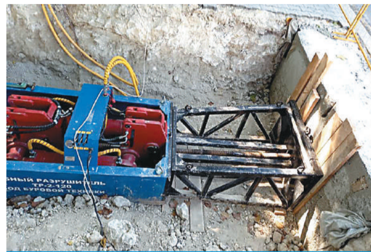
Установка «Статического разрушения» с тяговым усилием 120 тонн.
