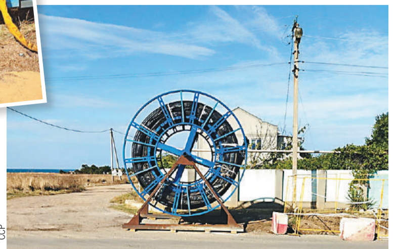
Метод «Полилайнер» применяется для пластиковых труб диаметром до 300 мм.
