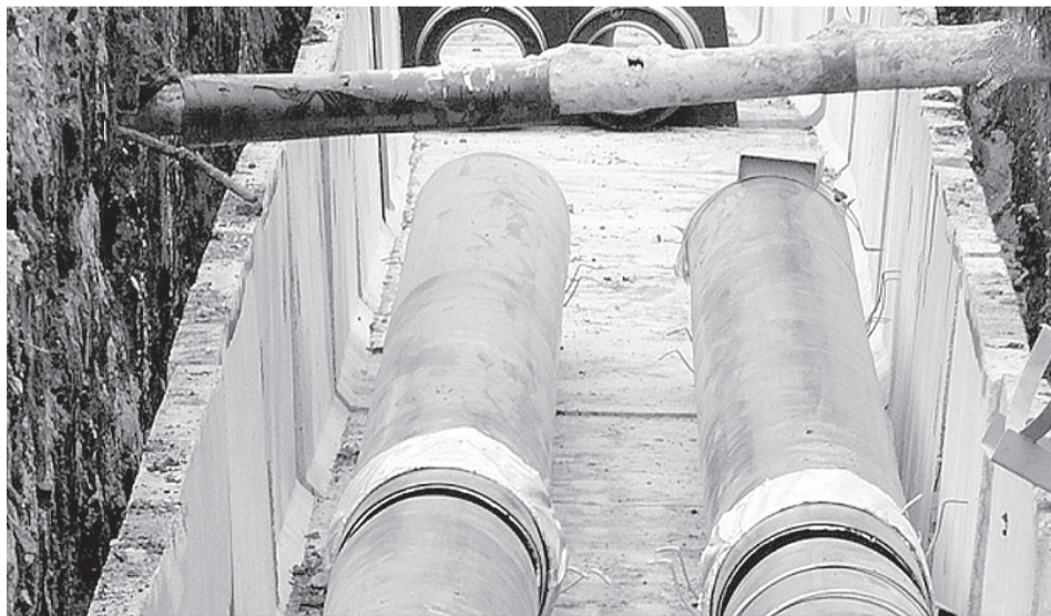
В межотопительный период теплотрассу капитально отремонтируют.
