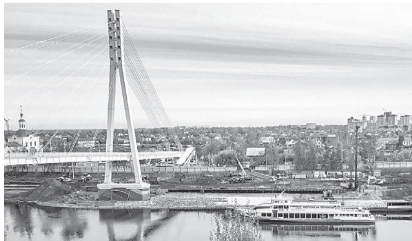
Работы по укреплению и благоустройству левого берега Туры начались в августе 2019 года.
