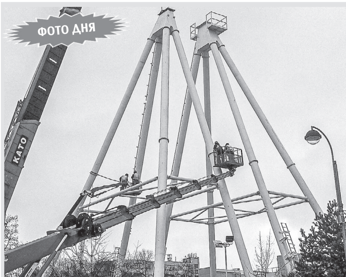
На Цветном бульваре в Тюмени полным ходом идет установка нового колеса обозрения, которое появится чуть ближе к цирку. Рабочие смонтировали опору, которая будет держать колесо, и в марте - апреле первые посетители смогут увидеть панораму Тюмени с высоты 19-этажного дома. Пока идет монтаж нового аттракциона, старый будет работать в прежнем режиме.
