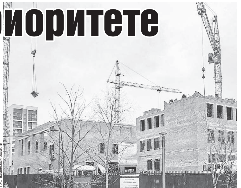
Строющаяся школа в 4-м Заречном микрорайоне.
