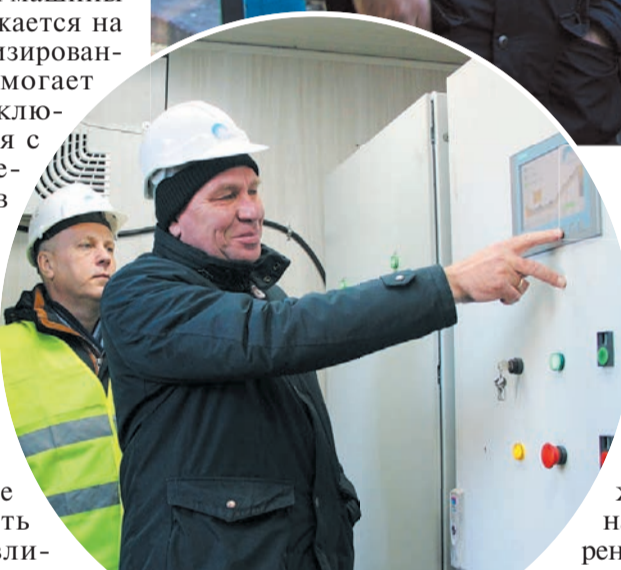
Официальный запуск закрытой конвейерной линии.
