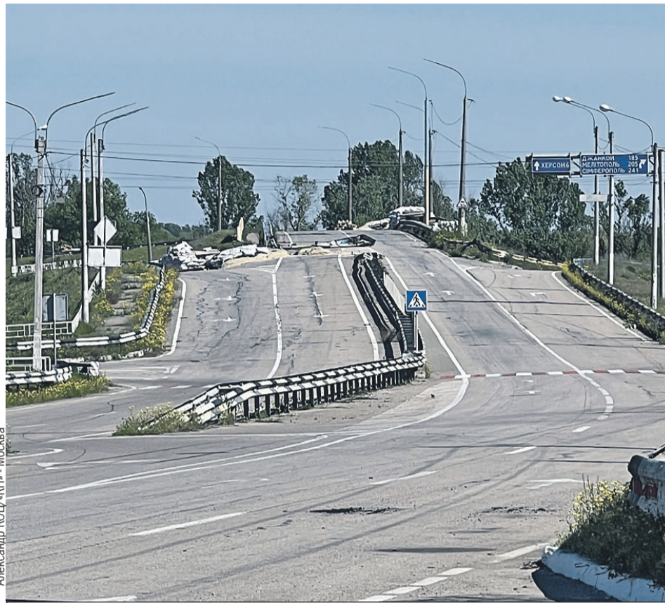
Подъезд с левой стороны Днепра к единственному мосту на Херсон. Сейчас переправы здесь нет. Мост давно взорван.
