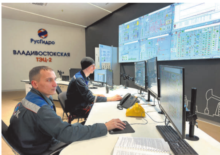
Программа подготовки Владивостокской ТЭЦ-2 включает ремонты котлов, турбин, замену трубопроводов, ремонт зданий и сооружений.
