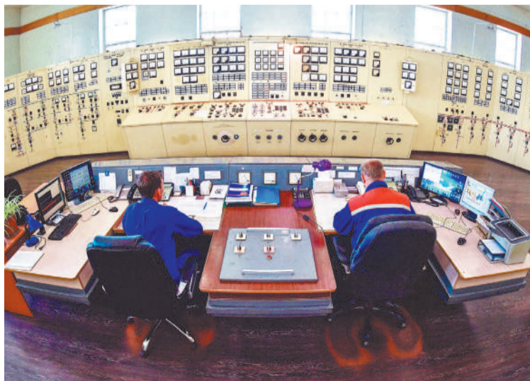
На Партизанской ГРЭС ремпрограмма включает 17 текущих и капитальных ремонтов на котельном и турбинном оборудовании.
