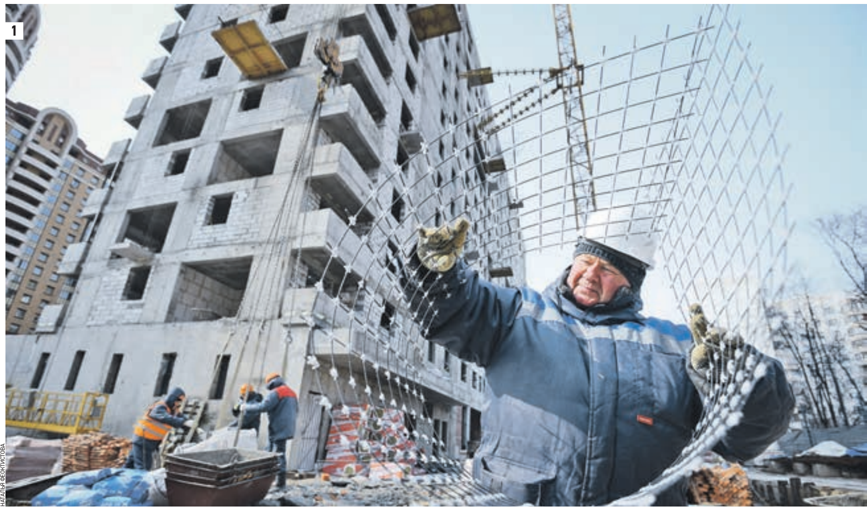
28 марта 2015 года 12:13 Бригадир Виталий Шуканов на строительной площадке необычного дома на улице Нижегородской демонстрирует наноконструктивную сетку — такая арматура не ржавеет и мало весит (1) Таким веселым и ярким дизайнеры и архитекторы предлагают сделать фасад уникального здания (2)
