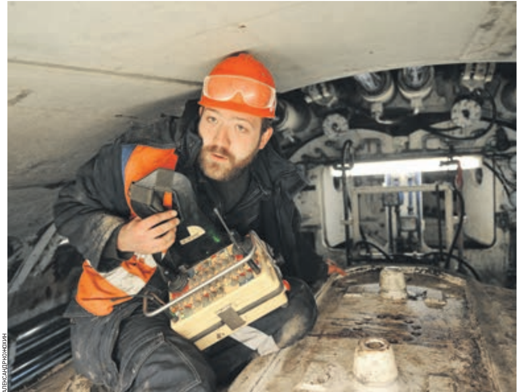
10 марта 15:45 Оператор пульта тоннелепроходческого комплекса Станислав Пономарев управляет машиной, прокладывающей тоннель на Кожуховской линии метро
