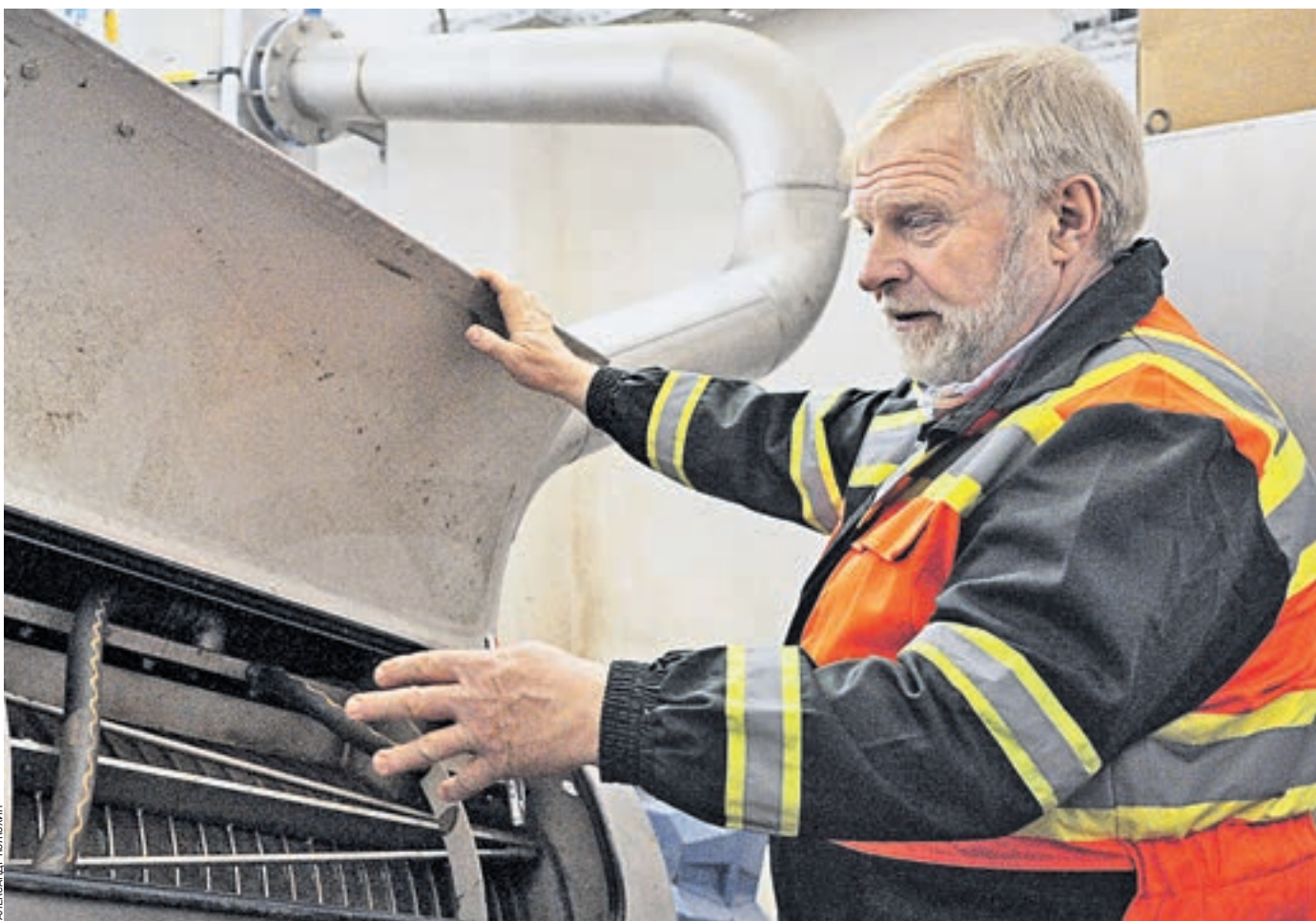
7 апреля 2017 года 12:32 Заместитель начальника управления технологическими работами ГУП «Мосводосток» Виталий Комляга показывает работу установки для осаднения и прессовки ила
