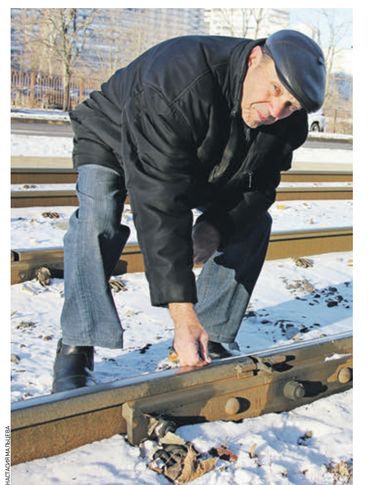
30 ноября 13:27 Михаил Непомнящий показывает зазор, из-за которого появляется грохот при движении трамвая
