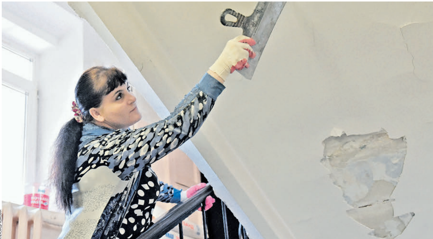
6 июля 2019 года. Штукатур ГБУ «Жилищник района Замоскворечье» Татьяна Иванова снимает старую штукатурку во втором подъезде дома № 10 по Большому Овчинниковскому переулку. Как пояснили эксперты, жильцы имеют право обратиться в Фонд капремонта и требовать провести некоторые работы в доме раньше
