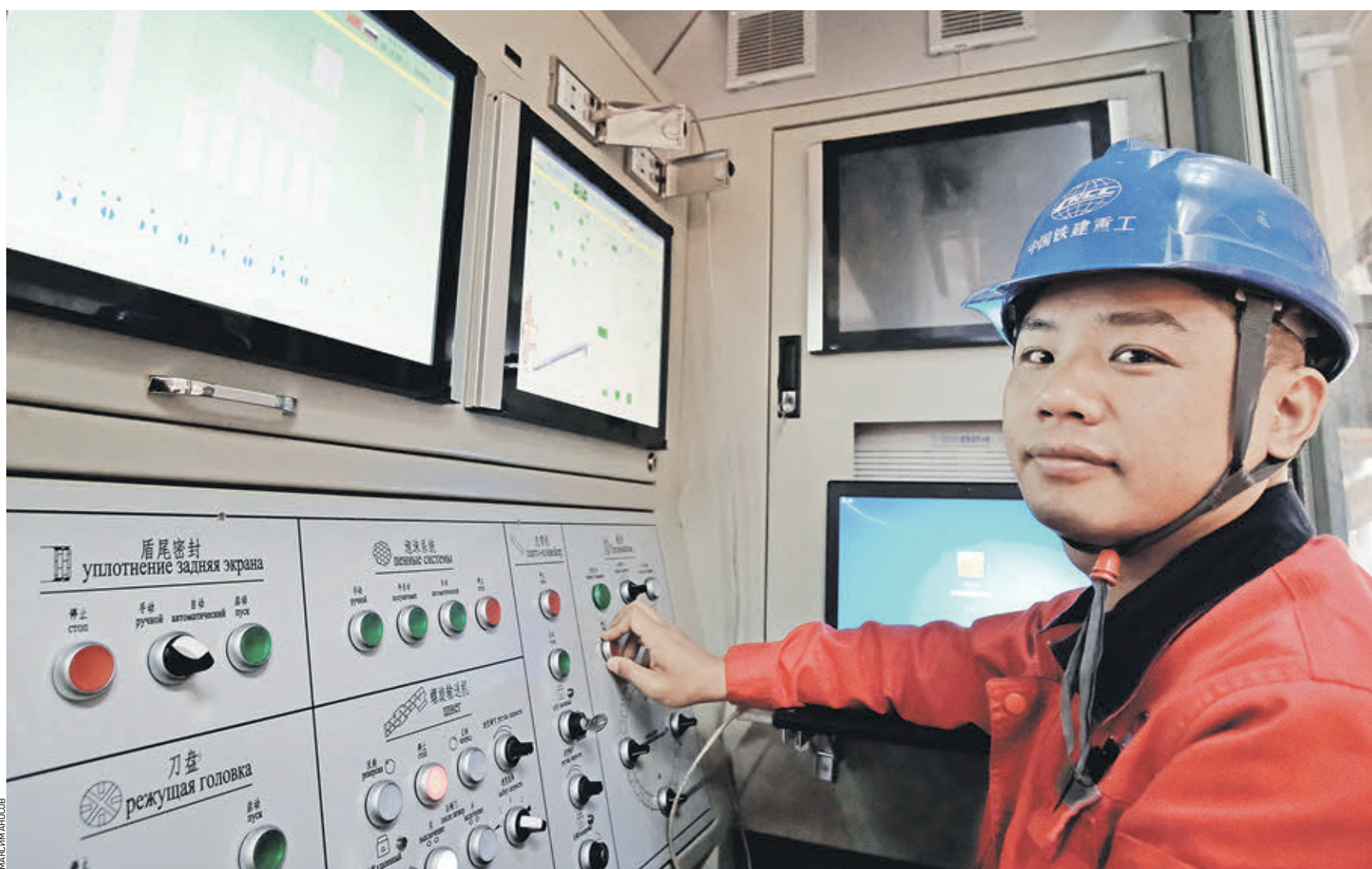
9 апреля 2018 года. Сотрудник китайской строительной корпорации CRCC Уан Бо готовит к запуску проходческий щит, который должен проложить тоннель от станции «Аминьевское шоссе» до станции «Давыдовское» Большой кольцевой линии метро
