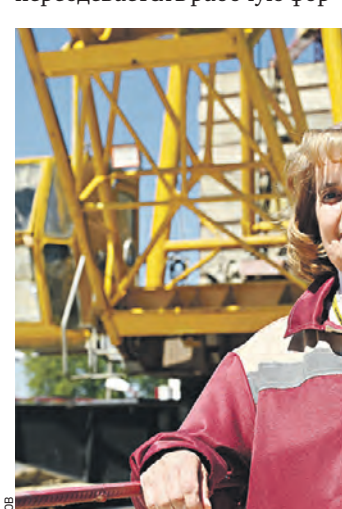
Вчера 13:15 Крановщица Мосметростроя Нелла Бетхер на строительной площадке
