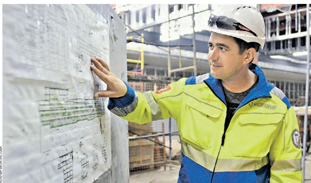
22 августа 2021 года. Инженер-строитель Владимир Животенко осматривает ход работ по сооружению пересадки между двумя станциями метро «Мичуринский проспект»
