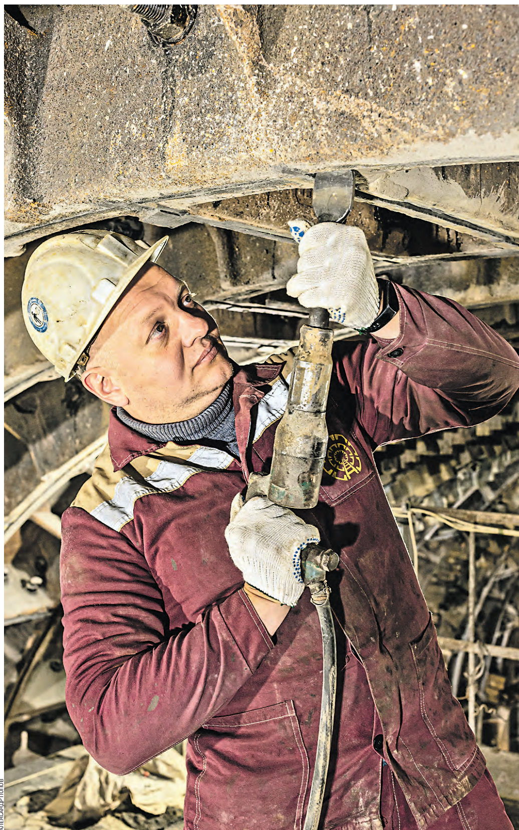
Вчера 10:03 Бригадир чеканщиков Максим Бережной трудится в тоннелях станции «Рижская» Большого кольца метрополитена. Работы не останавливались даже в праздничные дни, когда большинство горожан отдыхали
