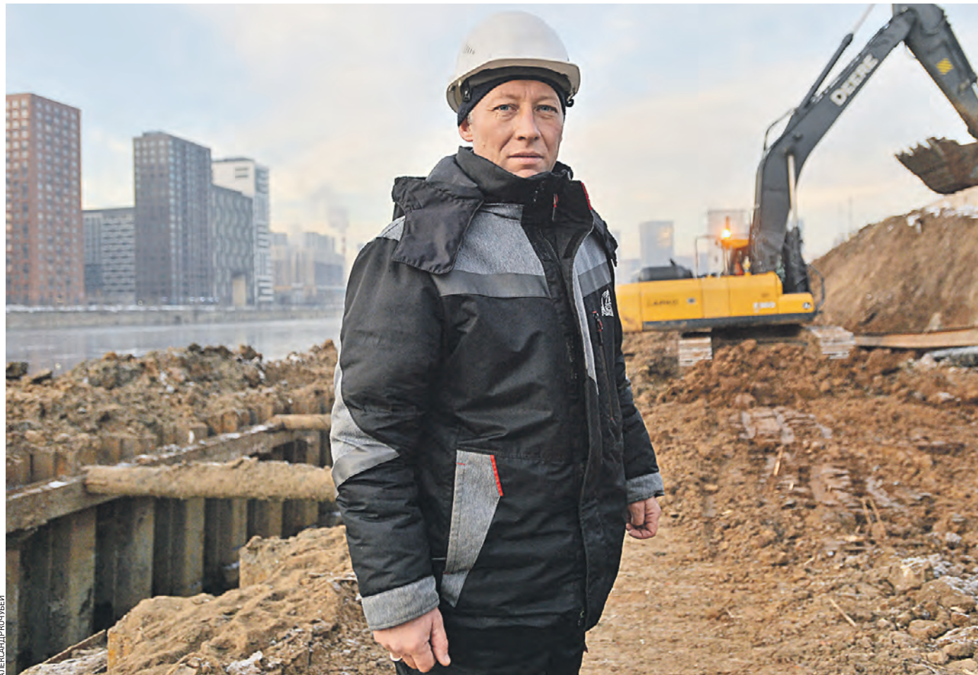
1 декабря 2022 года. Начальник участка строительной компании Евгений Рочев руководит процессом работ по укреплению берега Москвы-реки на Шелепихинской набережной
