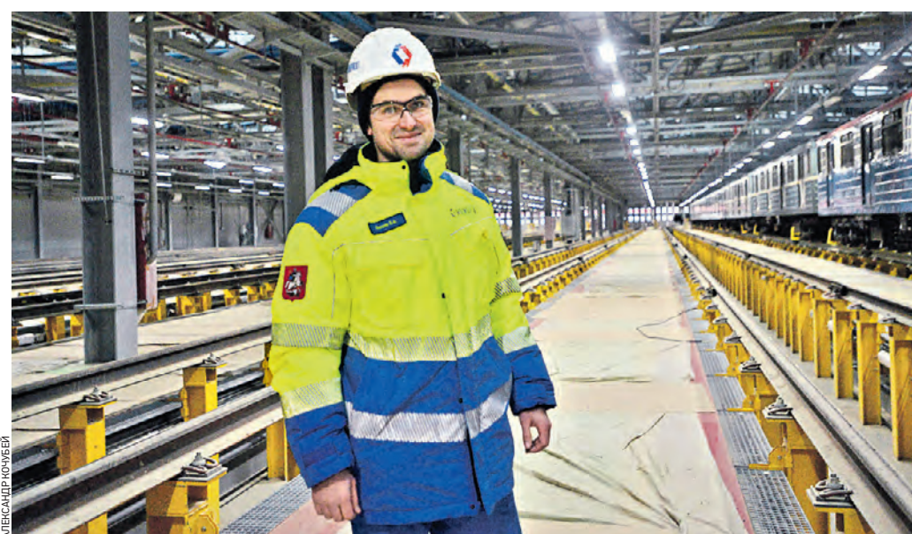
24 декабря 11:57 Сотрудник компании-генподрядчика Вячеслав Князев проверяет ход работ по возведению электродепе «Нижегородское»
