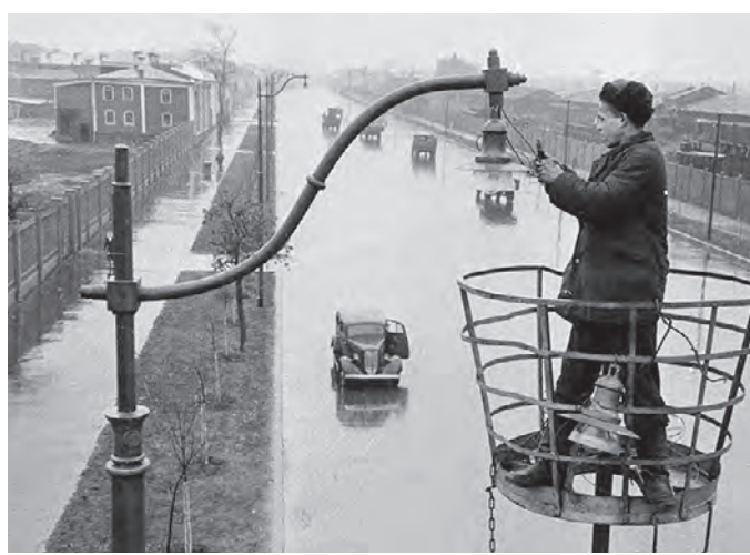
Москва, 1947 год. Рабочий на Нижегородской улице меняет старые фонарные светильники на новые
