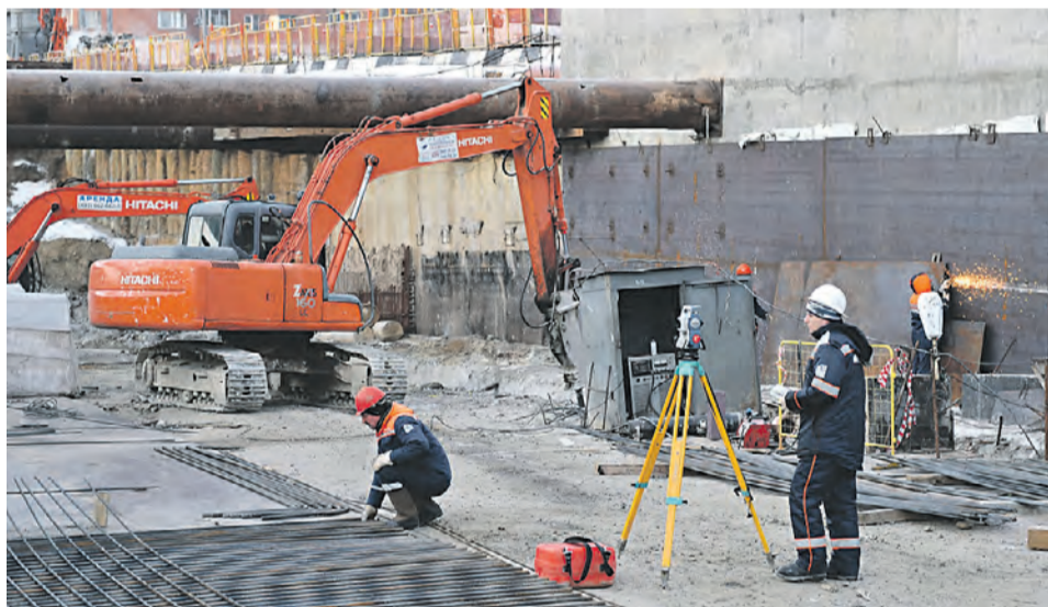
21 января 2015 года. Строительство Михалковского тоннеля
