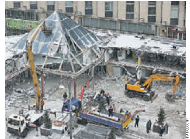
22 февраля. Сотрудники коммунальных служб сносят торговый центр «Пирамида» на Пушкинской площади
