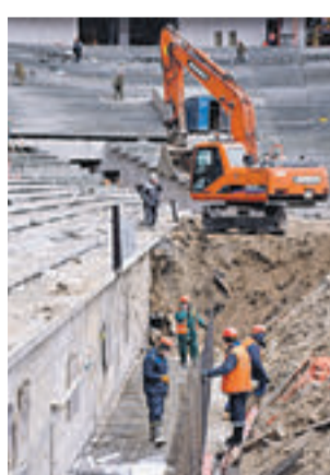
19 февраля 2016 года. Реконструкция Большой арены стадиона «Лужники»
