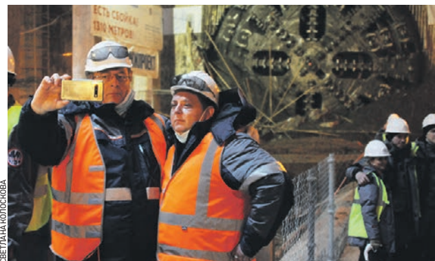
28 октября 2020 года. Выход тоннелепроходческого щита «Виктория» на станции «Печатники» Большой кольцевой линии метро
