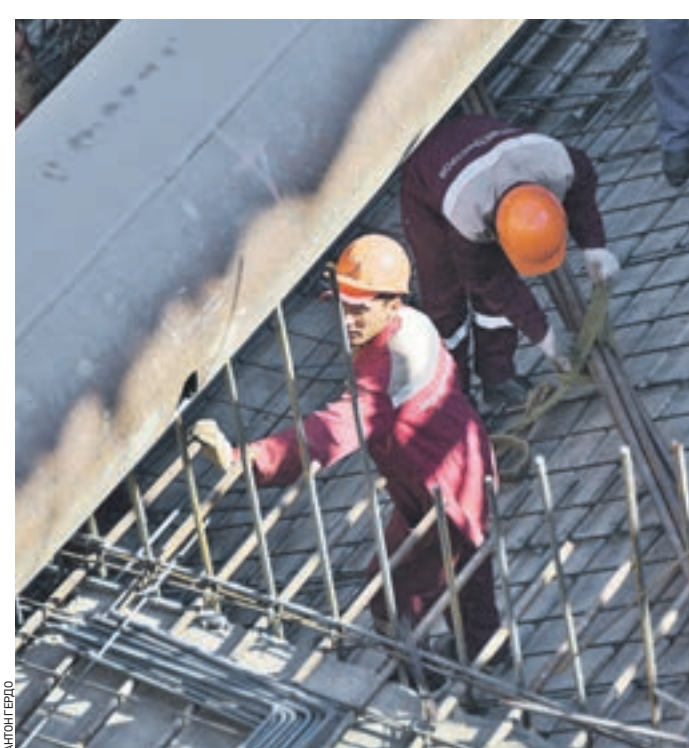
26 сентября 2015 года. Монтажные работы на строительстве новой станции метро «Саларьево»
