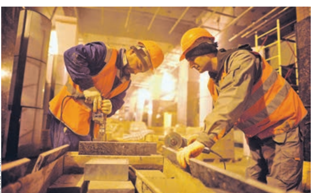
Вчера 12:11 Рабочие Левон Габриелян (слева) и Арсен Бутов готовят плитку для крепления на колонну на станции «Петровский парк» Третьего пересадочного контура метро
