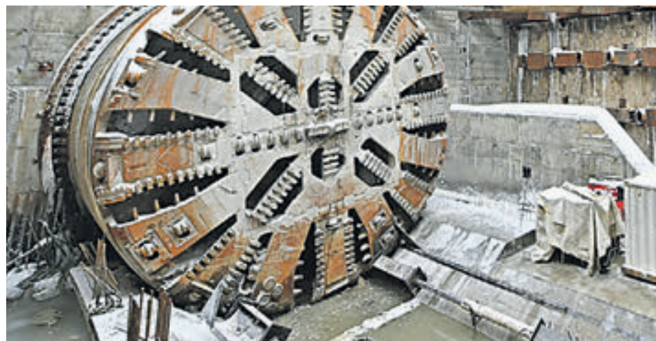
25 января 2018 года. Десятиметровый щит «Лилия» прошел свой первый тоннель
