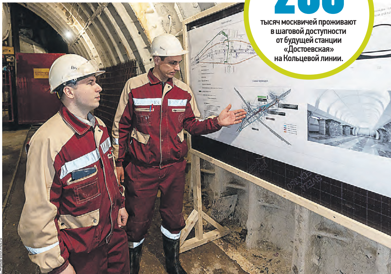
Строители метро показывают проект новой станции, которая расположится между «Новослободской» и «Проспектом Мира»
