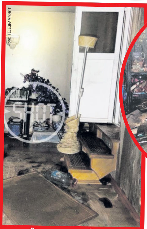
Лестница на второй этаж тоже пострадала от огня
